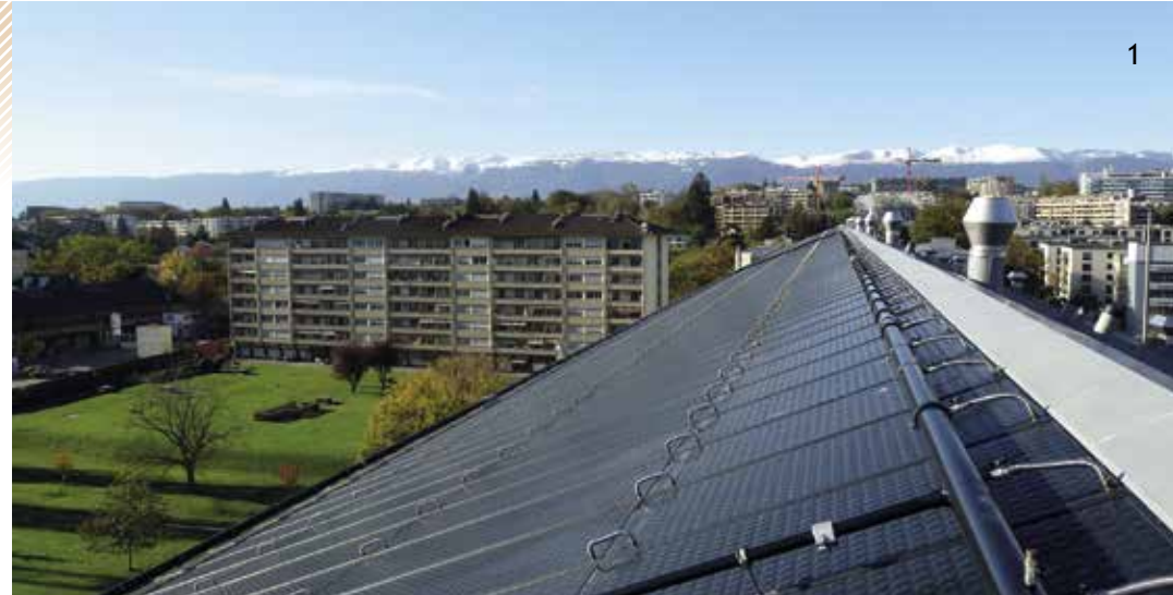
1. La Cigale constitue une des plus grandes rénovations durables suisses labellisées Minergie-P®. 2 et 3. La rénovation permet à ces constructions des années 50 de passer du statut de gouffre énergétique à celui de bâtiment exemplaire.
