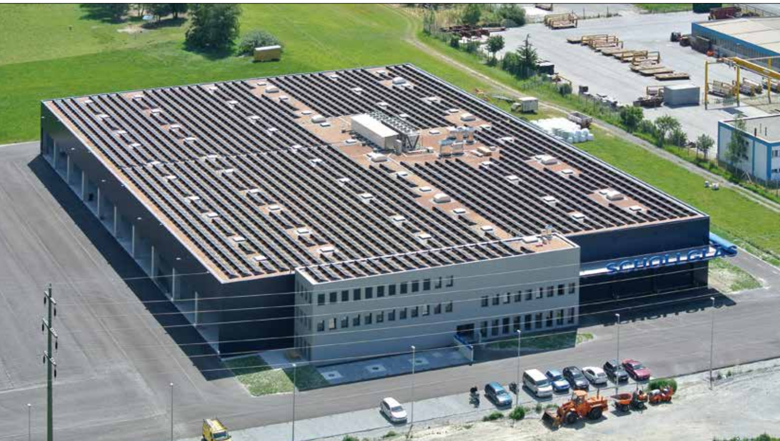
L'usine de vitrage isolant Scholl AG à Steg en Valais a reçu un prix dans la catégorie «Bâtiments, nouvelles constructions», primée pour la production annuelle de 500 000 kWh, soit 68% de ses besoins.
